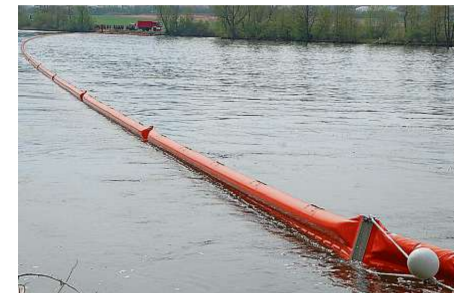
360 Meter quer über die Donau läuft die Ölsperre.
